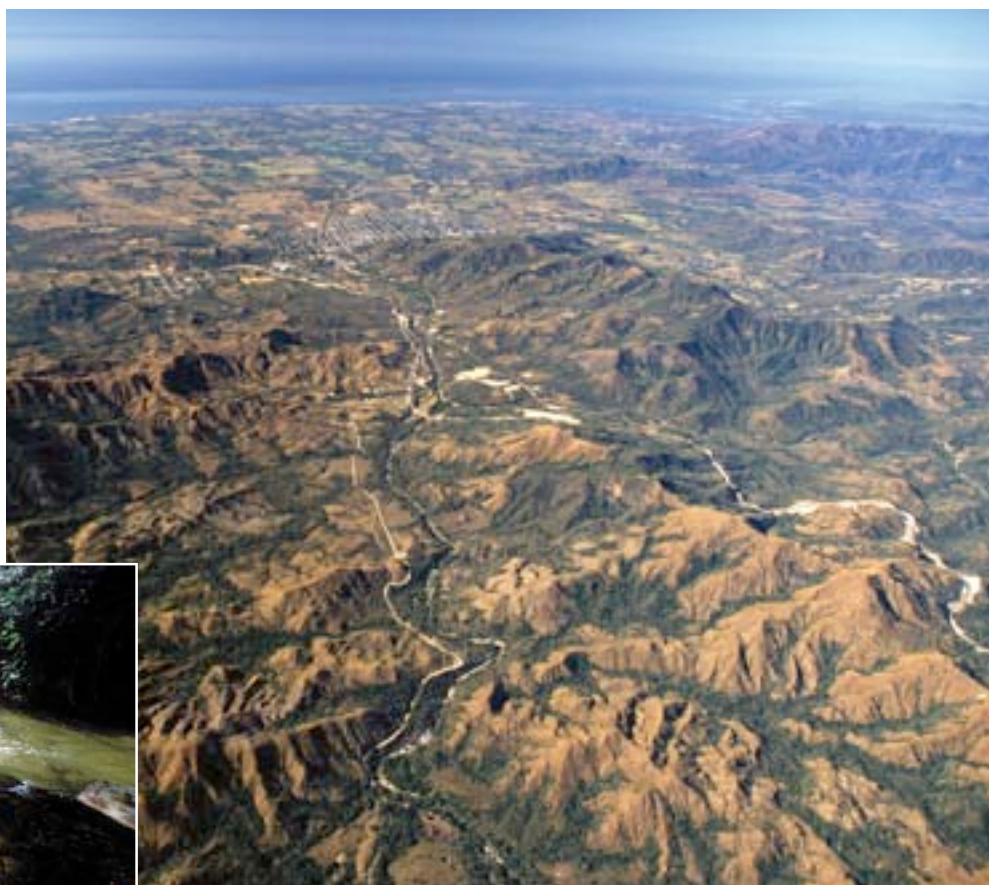
Vista aérea de la parte baja de la erosionada cuenca Lagartero; al fondo se aprecia Arriaga, y a la derecha las obras de la autopista en construcción.
